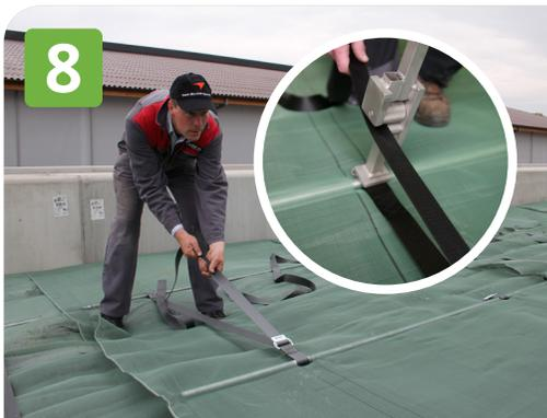
Verbinden Sie alle Zugösen mit den Riemen und ziehen Sie die Bahnen fest. Falls erforderlich, verwenden Sie den Spanner, um die Bahnen weiter zu spannen. Führen Sie das Band durch den Spalt zwischen der Rolle des Spanners und der darunter liegenden Platte. Setzen Sie den Fuß des Spanners hinter das Metallrohr und ziehen Sie den Spanner zu sich heran. Wiederholen Sie diesen Vorgang, bis er straff ist. Falls erforderlich: Ziehen Sie nach einigen Wochen erneut nach.
