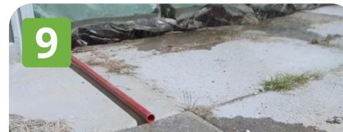
Verbinden Sie die zwei roten PVC-Rohre mit den grauen PVC-Rohren an der Eingangsstelle der Fahrsilo als Markierung und für den Regenwasserablauf.
