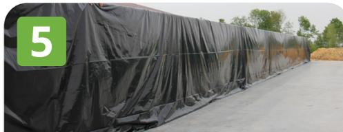
Legen Sie die Folie darüber. Achten Sie auf eine Überlänge von 10-20 cm auf dem Boden. So wird verhindert, dass Wasser in die Silage läuft. **Anweisungen zur Folie finden Sie auf der nächsten Seite.**
