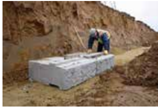
De basisblokken plaatsen en nivelleren
