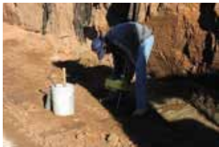
Verdichting regelmatig controleren
