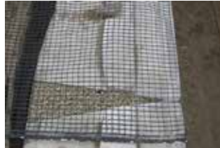
Geogrid plaatsen (indien vereist)
