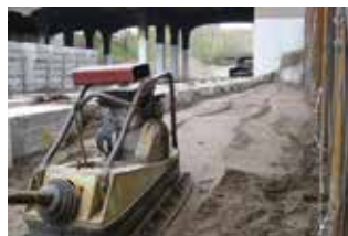
Aanvullen en verdichten
