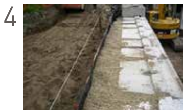
Mise en place du matériau de drainage
