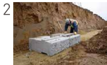
Mise en place des blocs de base et nivellement
