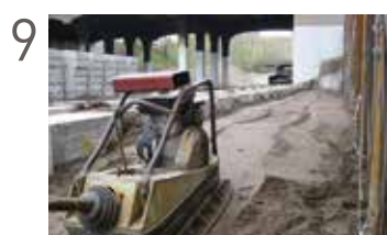
Remblayage et compactage
