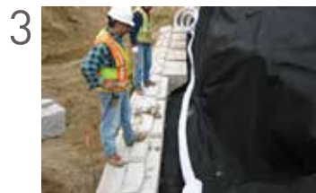
Mise en place de la nappe filtrante
