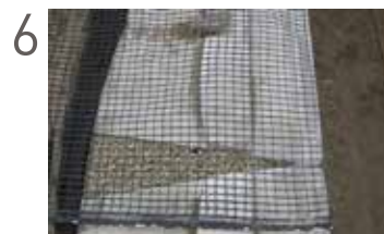
Mise en place du géogrille (si exigé)
