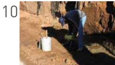
Contrôle régulière du compactage
