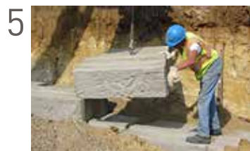
Mise en place des couches du mur de soutènement autoportant
