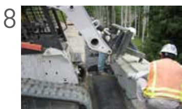
Mise en place des couches supplémentaires du mur de soutènement avec géotextile
