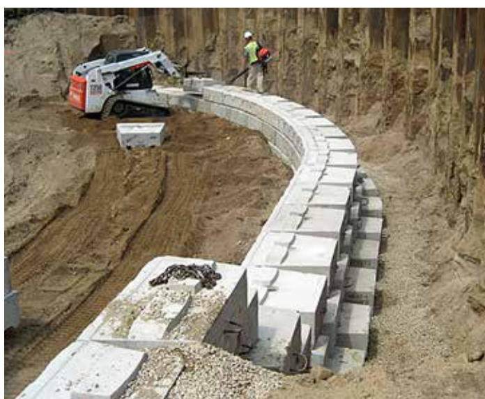
Mise en place des couches supplémentaires du mur de soutènement avec géotextile
