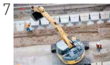
Mise en place des couches supplémentaires du mur de soutènement autoportant
