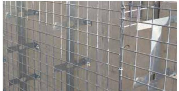
Colonne fix avec plaquette et vis
