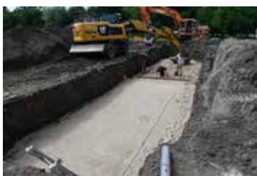
1) Creuser et égaliser des puits
