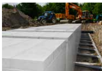
6) Pose de 8 dalles de couverture sur le caveau
