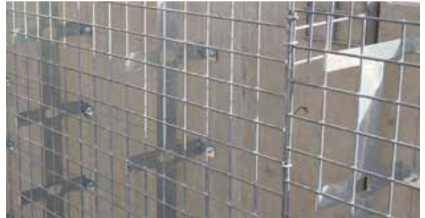
Colonne fix avec plaquette et vis
