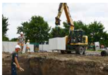
3) Mise en place des caveaux
