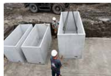
4) Alignement des caveaux l'un à côté de l'autre
