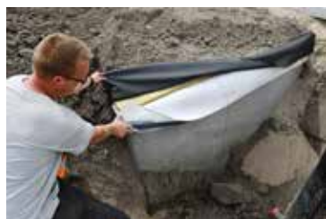
9) 5 couches sur les plaques supérieures : feuille, tissu, isolation, tissu, feuille
