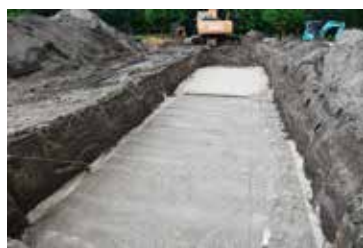
2) Pose d'un filet
