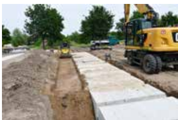
8) Enfoncer la terre autour des caveaux
